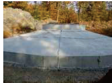
Massif d'éolienne avec ceinture équipotentielle pour MALT
