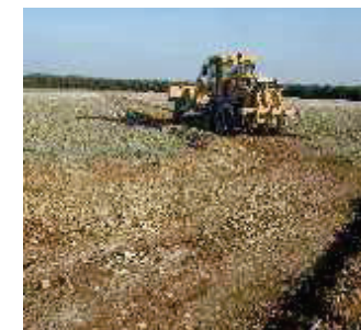
Décapage pour câblage
