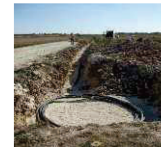
Pose de réseaux HTA
